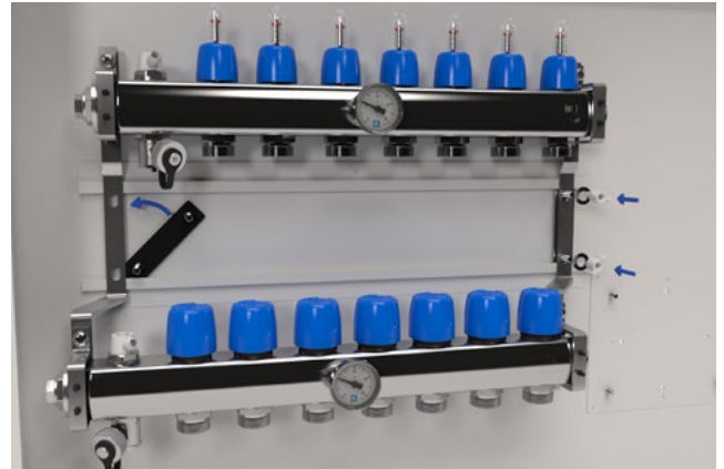
LK Jakotukin RF asennus.
