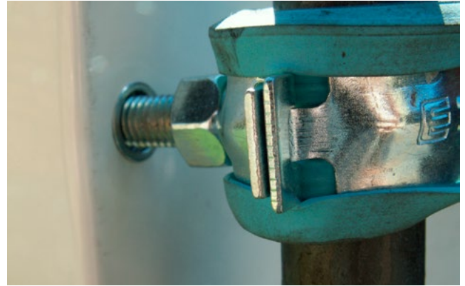
Lähikuva telineen kiinnityksestä kaappiin.
